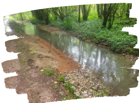
Le 7 juillet : Travaux de restauration de frayères à truites à Breteuil
