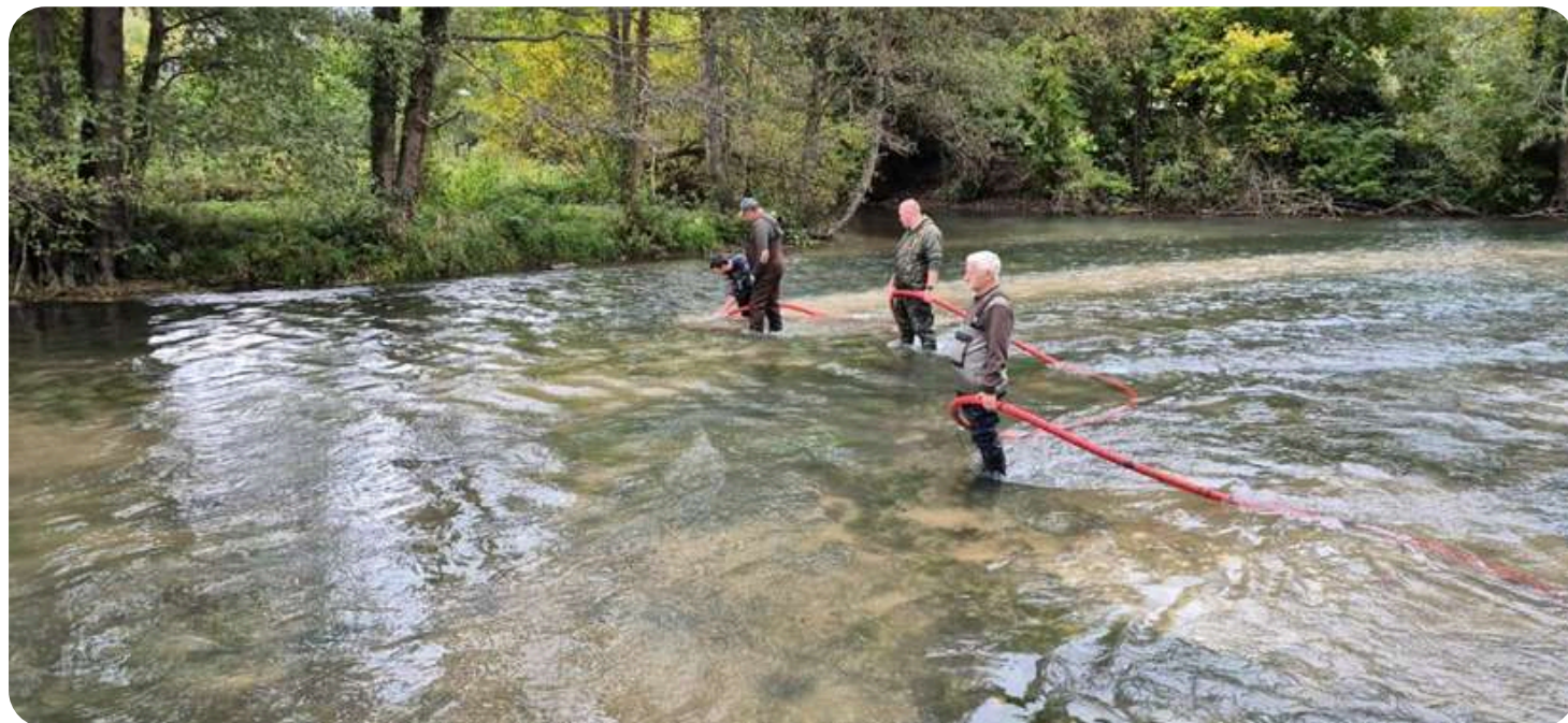
Décolmatage sur le Thérain à Beauvais
